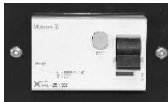
Schakelaar 32 A D Hoofdschakelaar 30 mA
